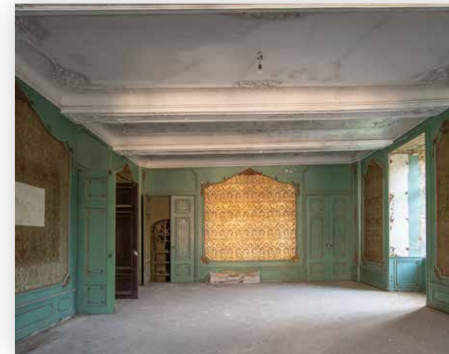
De Groene Zaal: bijzondere wandafwerkingen vermoedelijk daterend uit de verbouwing van 1926.
