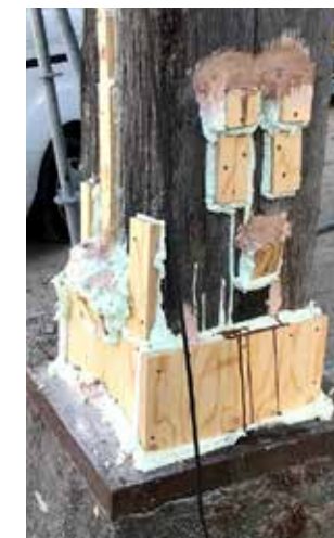
POOT VAN DE KRAANBAAN TIJDENS RESTAURATIE: BEKISTING OM DE EPOXY HEEN.
