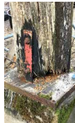
POOT VAN DE KRAANBAAN VOOR RESTAURATIE.
