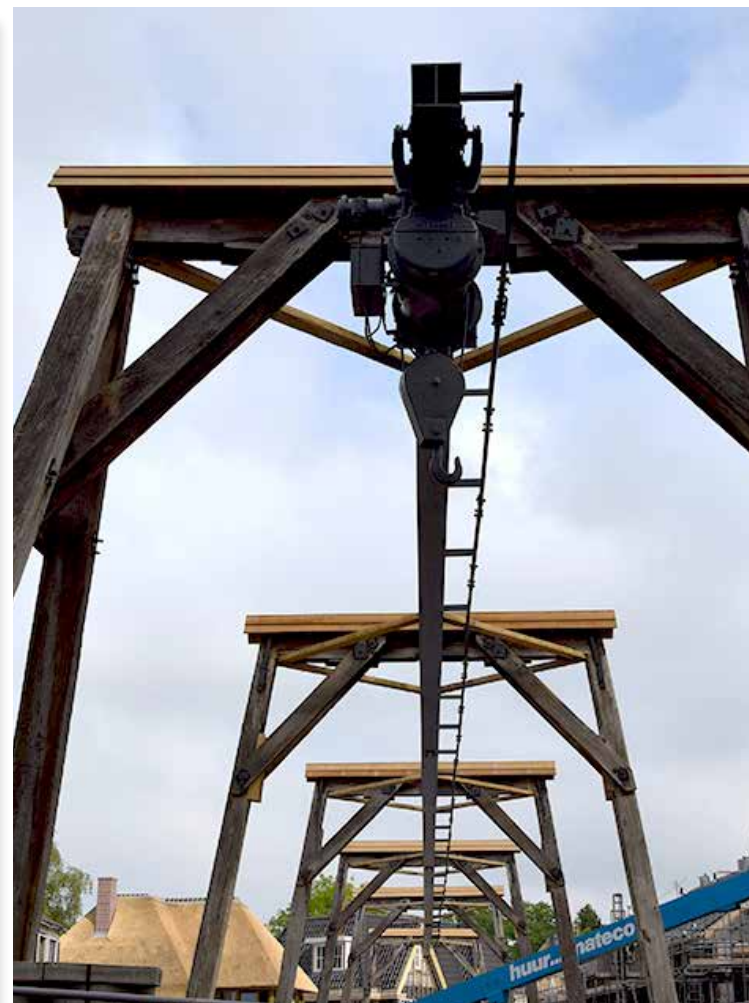
BOVENWERK VAN DE KRAANBAAN NA RESTAURATIE.
