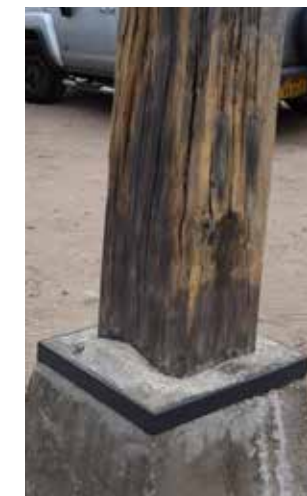
POOT VAN DE KRAANBAAN NA RESTAURATIE: DE EPOXY IS ALS HOUT BESCHILDERD.
